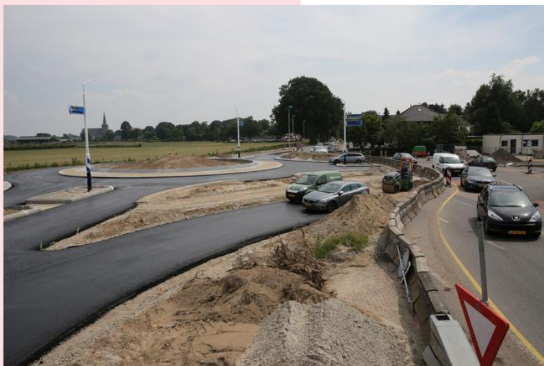
Rijksstraatweg ter hoogte van de noordelijke rotonde.
